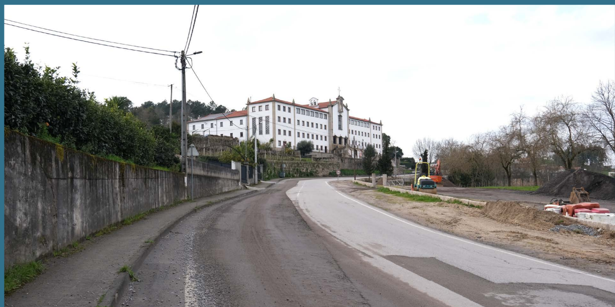
Construção de Redes de Água e Saneamento em Avelasadas e Rosém
