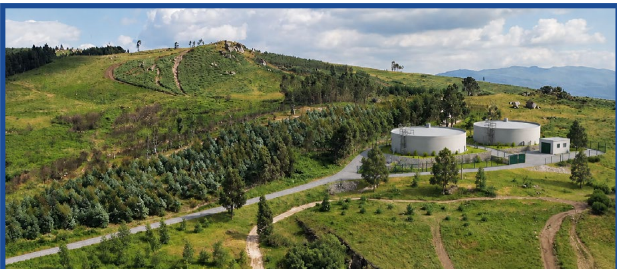
FUTUROS RESERVATÓRIOS DE ÁGUAS DE MONTEDEIRAS
