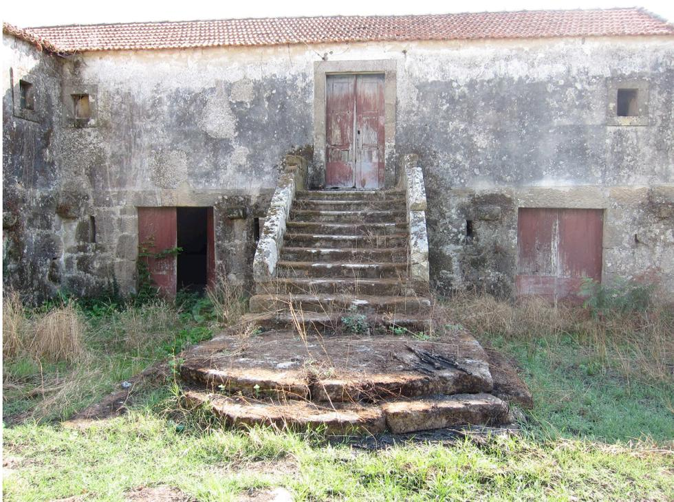
Fig. 16 – Escadaria provida de guardas em granito de acesso ao piso superior da Casa da Avelosa
