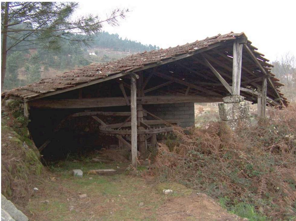
**Fig. 30** - Estrutura de cobertura do engenho de Pesadorias
