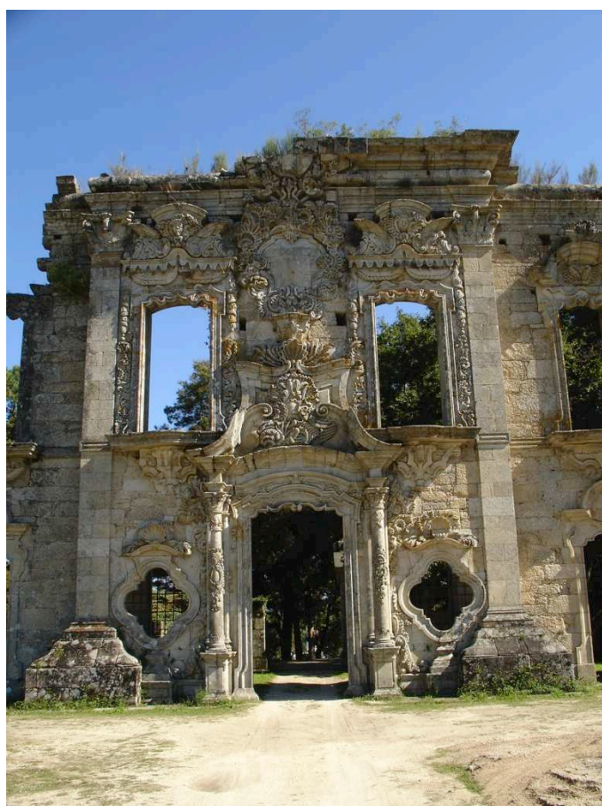
Fig. 72 – Porta central avançada das Obras do Fidalgo
