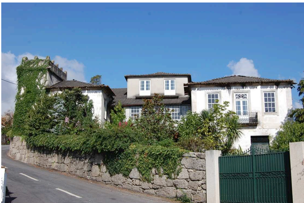
Fig. 12 - Vista geral sobre a Casa da Ponte
