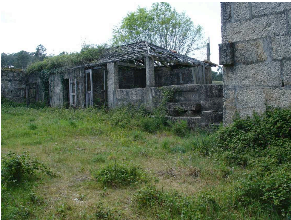
Fig. 84 – Dependências de apoio à atividade agrícola em ruínas da Casa de Cânica
