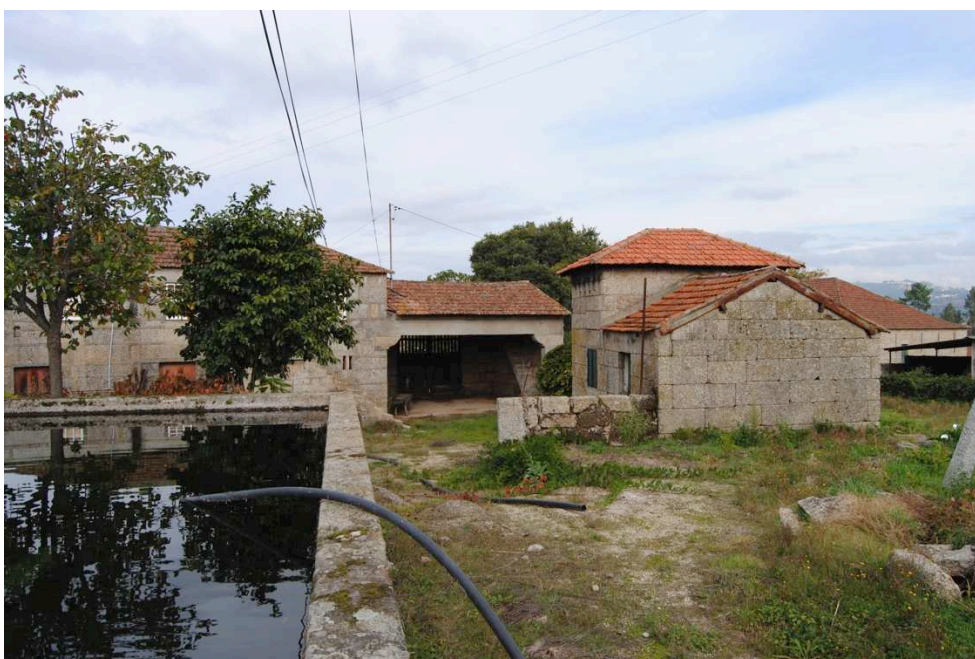
Fig. 75 - Panorâmica geral sobre o pátio interior da Casa dos Quartéis
