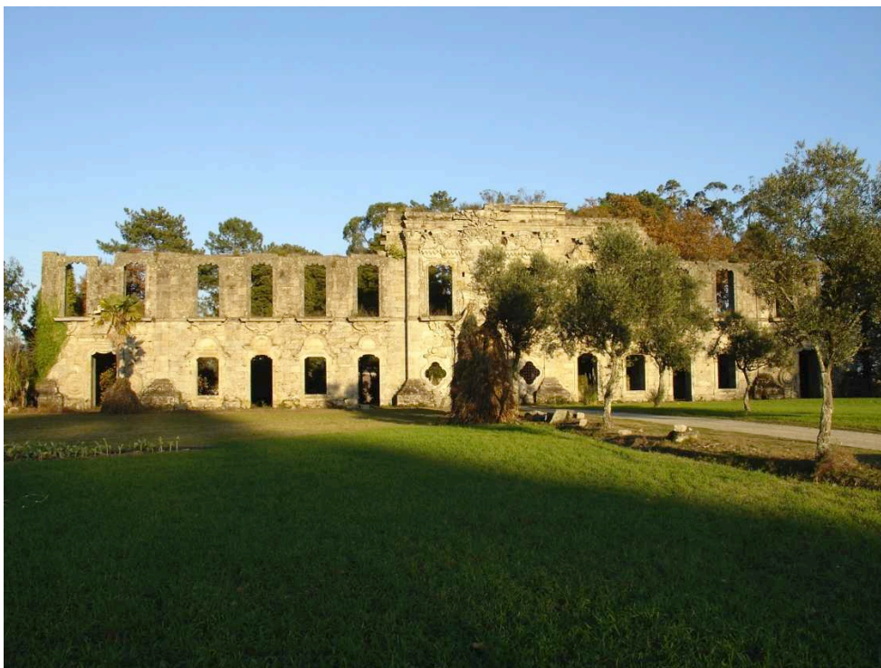
Fig. 71 – Enquadramento geral frontal das Obras do Fidalgo
