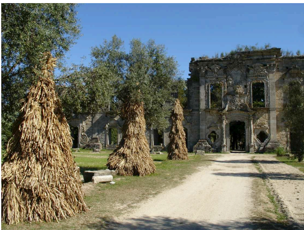
Fig. 70 – Caminho de acesso e vista parcial da frontaria das Obras do Fidalgo
