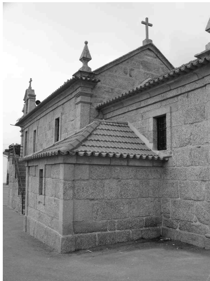
Fig. 53 – Alçado lateral Este da capela de São Sebastião
