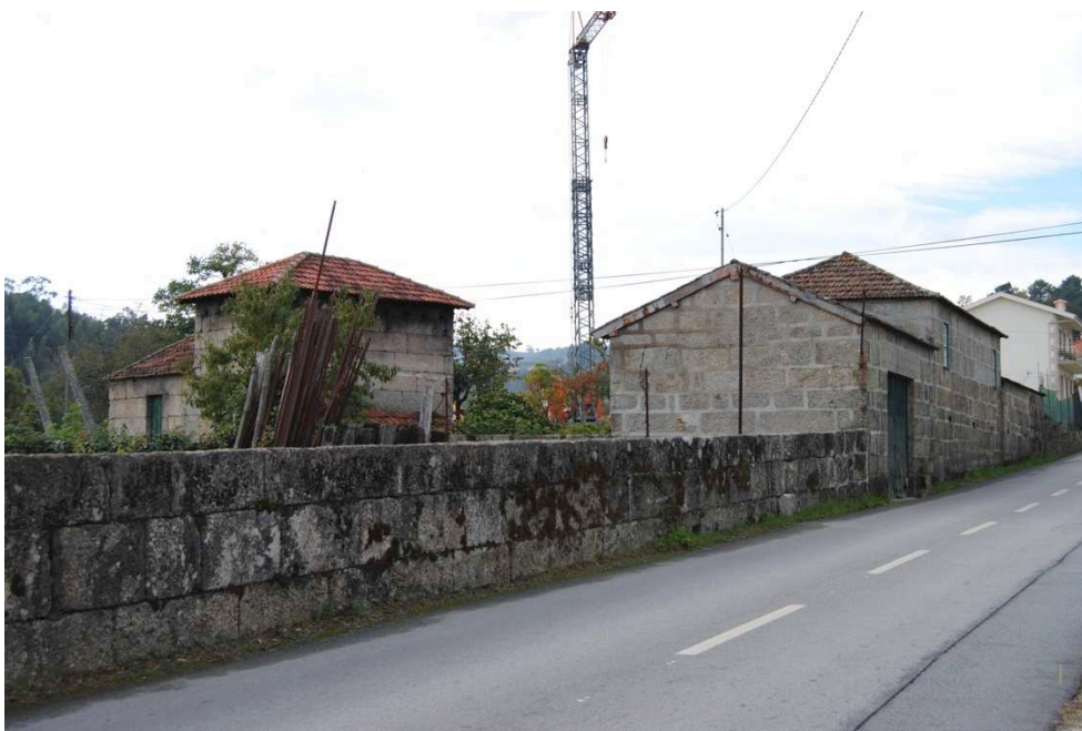
Fig. 74 - Vista geral sobre a Casa dos Quartéis
