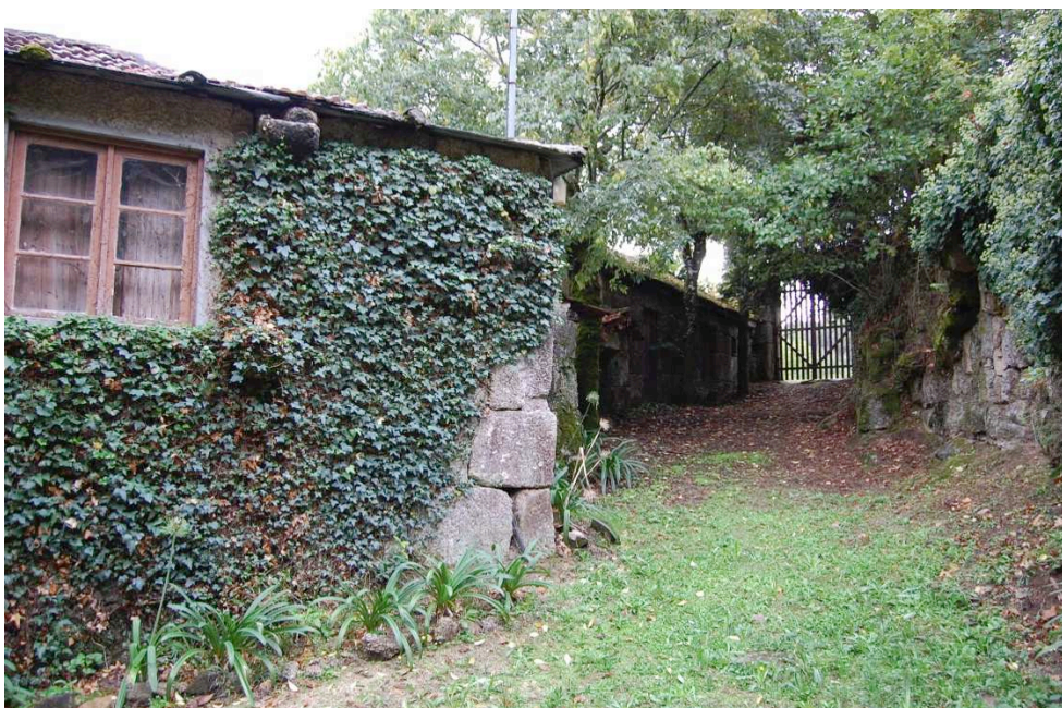
Fig. 88 - Área de acesso ao interior do terraço da Casa de Presigo
