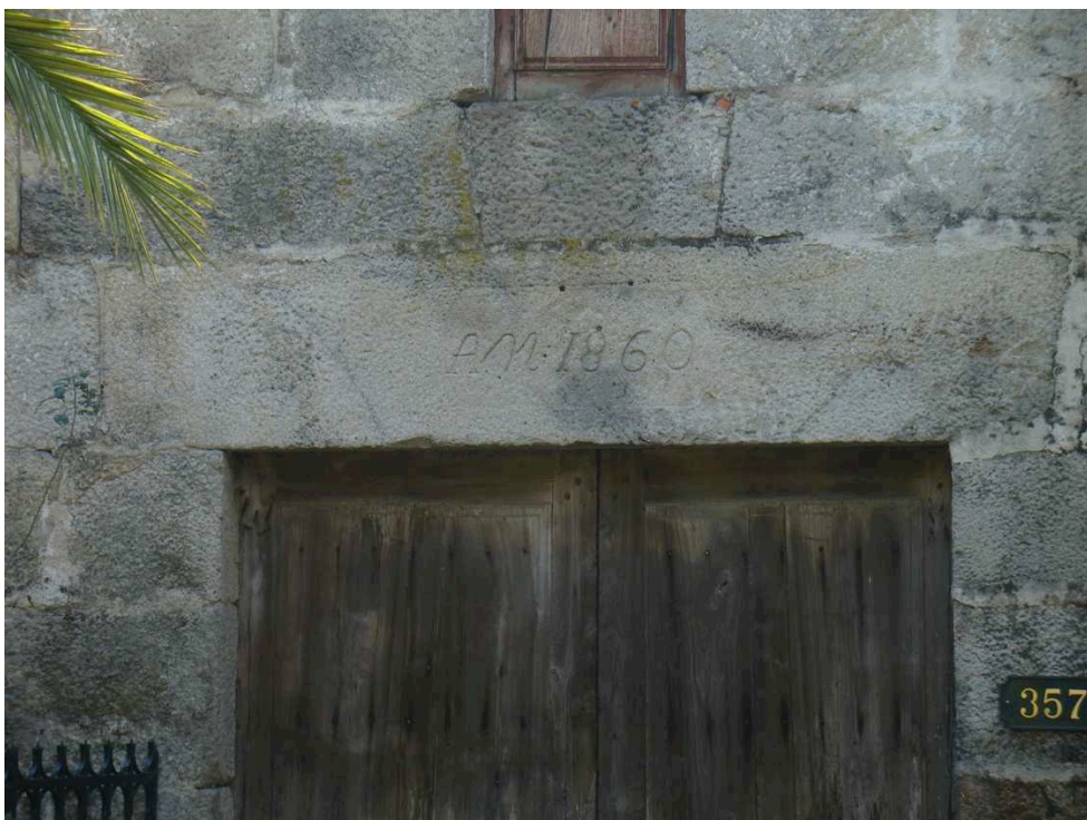
Fig. 82 - Lintel datado sobre porta da Casa de Remongoso
