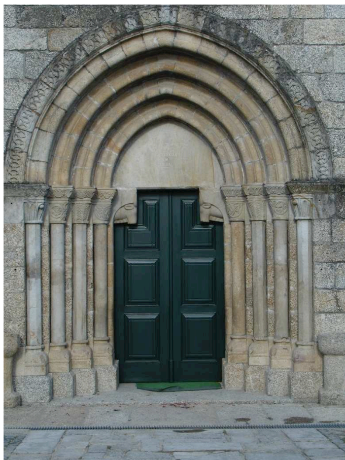
Fig. 18 - Portal principal da igreja de Vila Boa de Quires
