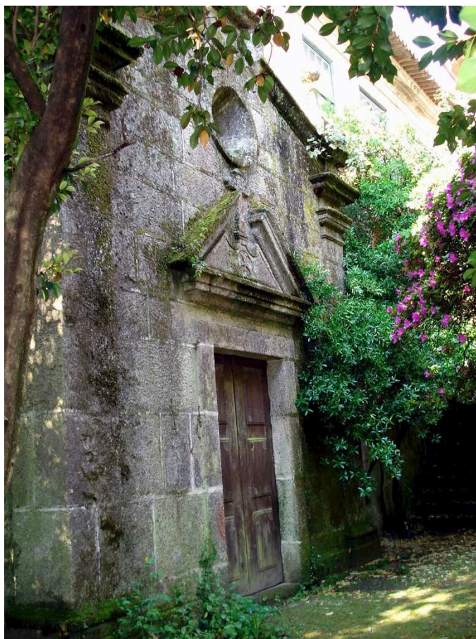
Fig. 61 - Fachada da capela de N. Sra. da Conceição
