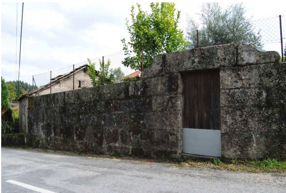
Fig. 81 - Vista parcial sobre a Casa de Remongoso
