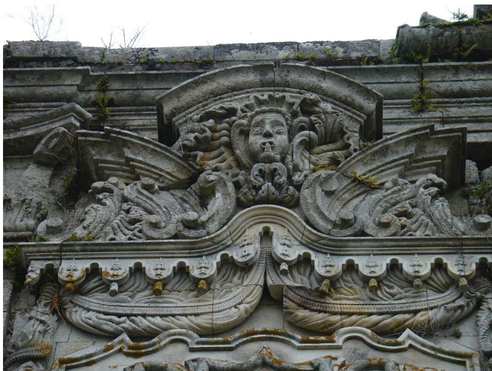
Fig. 73 – Pormenor decorativo na frontaria avançada das Obras do Fidalgo
