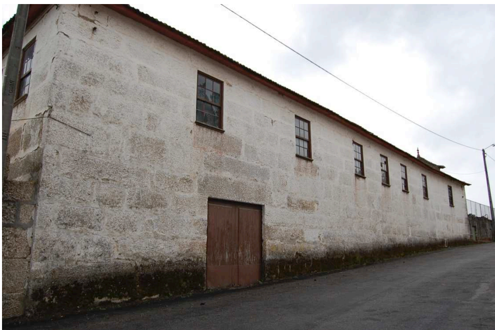
Fig. 77 - Alçado da Casa das Traginhas voltado para via de acesso local
