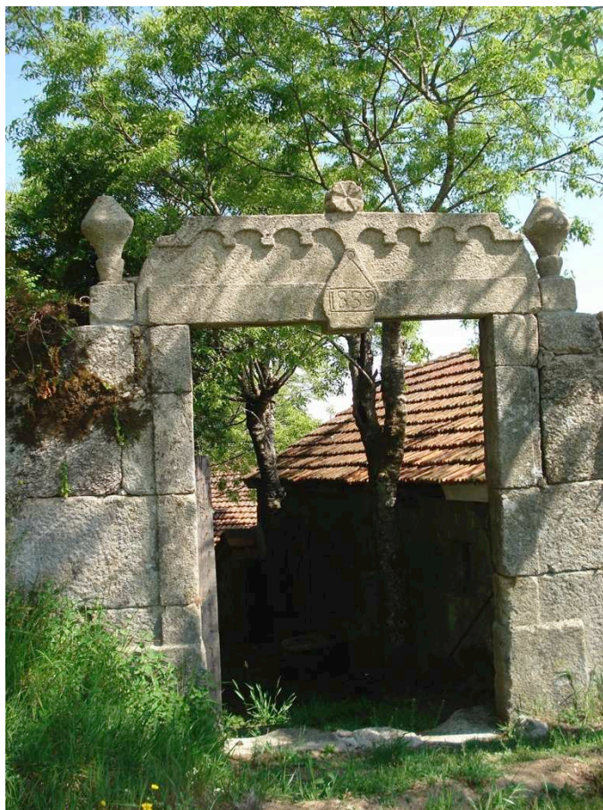
Fig. 89 - Portão com lintel datado de 1839 da Casa de Presigo
