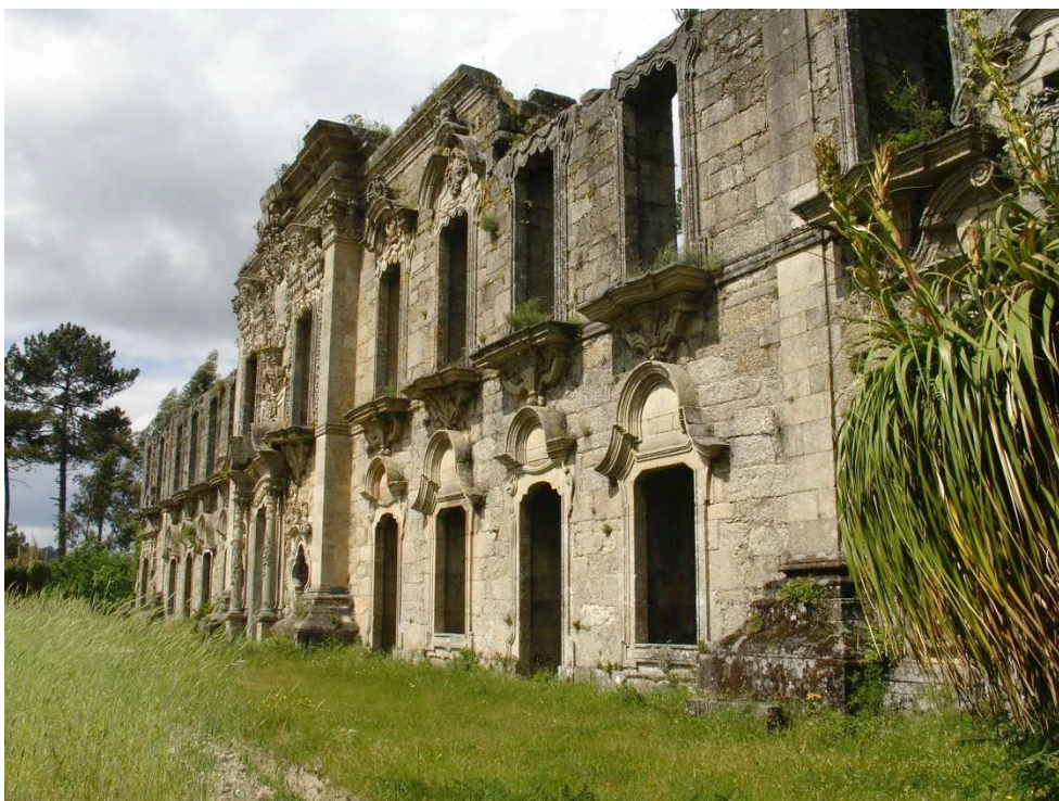
Fig. 69 – Vista geral lateral sobre as Obras do Fidalgo
