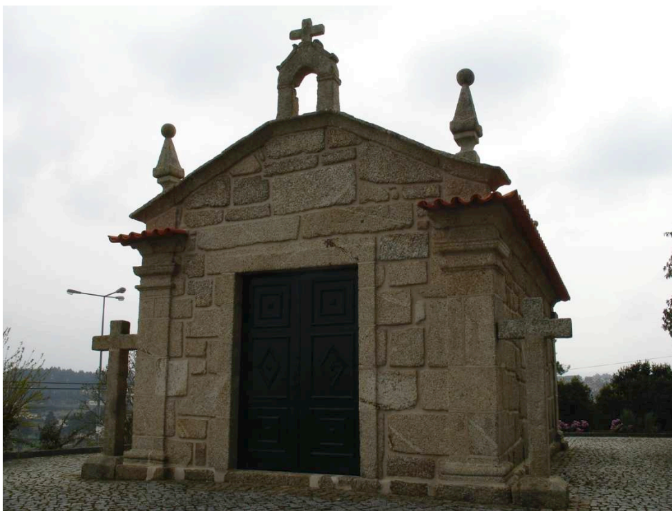
Fig. 51 - Vista geral sobre a capela de Divino Salvador
