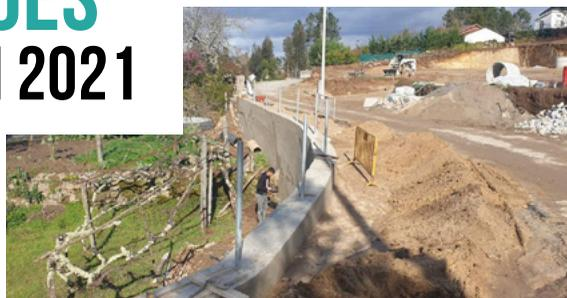
Neste conjunto de obras estão incluídas: pavimentação em cubos de granito, pavimentação em tapete betuminoso, pavimentação em microaglomerado, reabilitações de tapete betuminoso e construções de muros de suporte.
